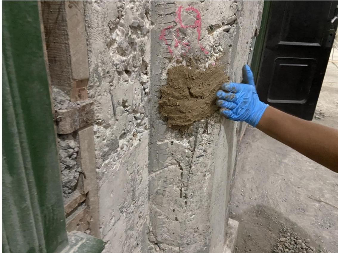
補強方法為塗佈新舊混凝土接著劑，再使用環氧樹脂砂漿修補。
